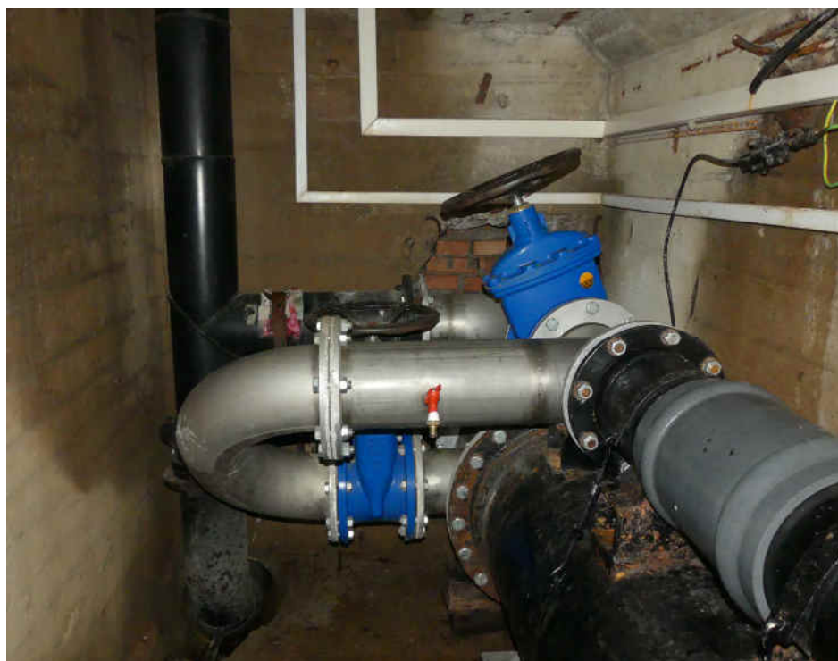
Obr. 4 – Zaústění obtokového potrubí DN 200 do DN 500
