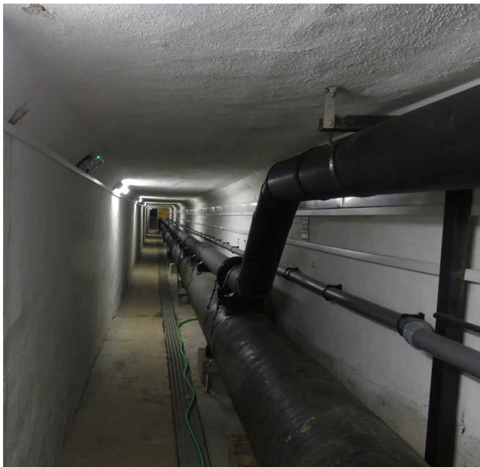
Obr. 3 - Trasa obtokového potrubí DN 200
