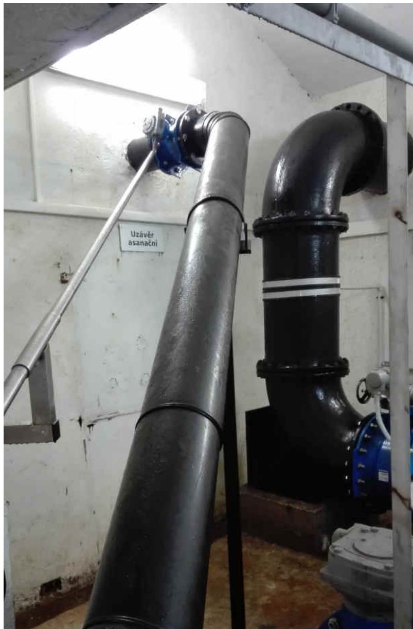
Obr. 2 - Prostup obtokového potrubí DN 200 v odběrném objektu
