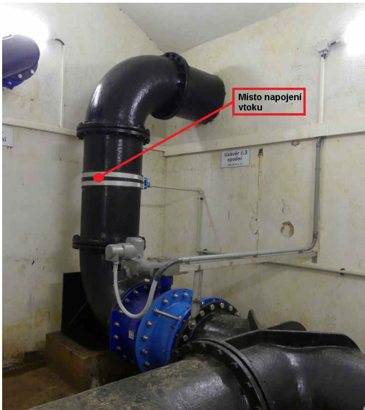
Obr. 5 – Napojení nového obtokového potrubí
