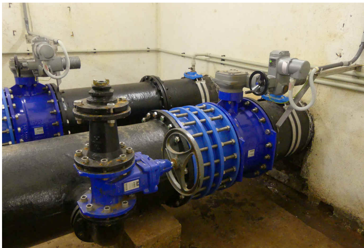
Obr. 1 - Klapkové uzávěry DN 500 - horní a střední odběr
